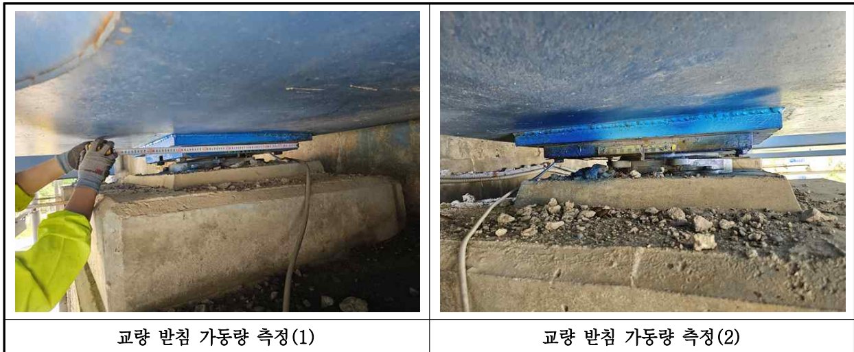
【사진 4.3.15】 교량받침 이동량 측정
