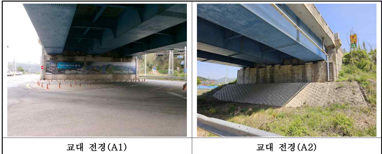
【사진 4.3.8】 교대 전경
