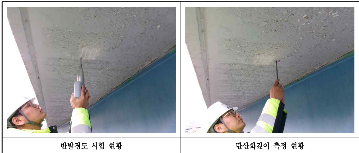
【사진 4.4.1】 콘크리트 내구성조사 현황
