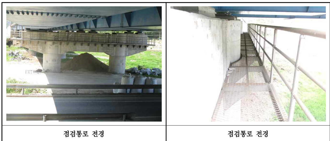
【사진 4.3.25】 교량 점검시설 전경
