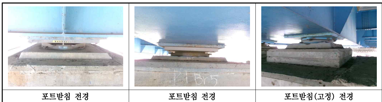
【사진 4.3.12】 교량받침 전경
